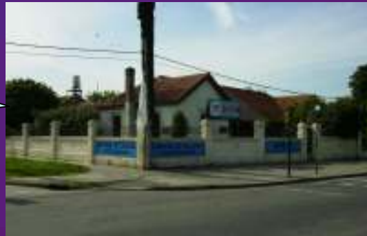
LABORATORIO ROSARIO Bv. Avellaneda 690 bis –Rosario J.J.Paso 675 -Rosario Superficie Cubierta: 270 m 2
